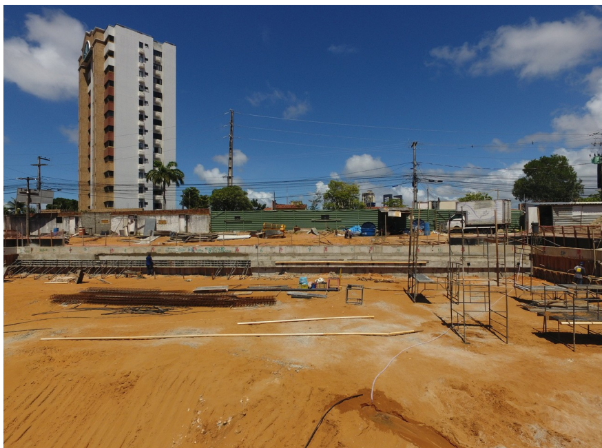
Figura 5: contenção 1 trecho C, estacas e viga de coroamento finalizadas.
