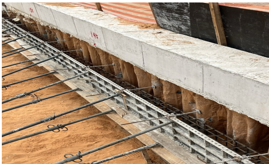
Figura 8: concretagem viga dos tirantes, contenção 1 trecho B.
