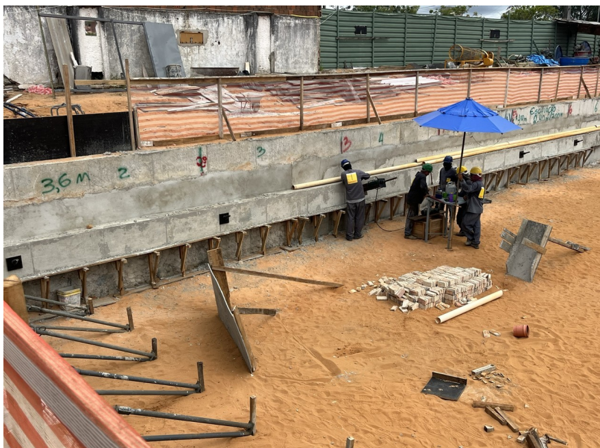
Figura 7: Viga de tirantes contenção 1 trecho C.
