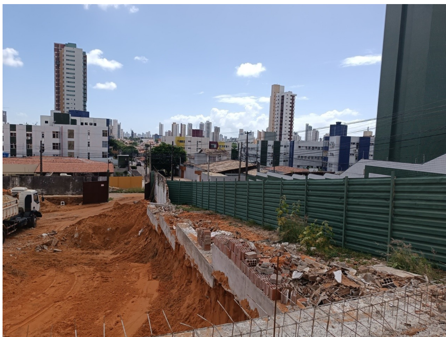
Figura 2: Proteção em tapume metálico.
