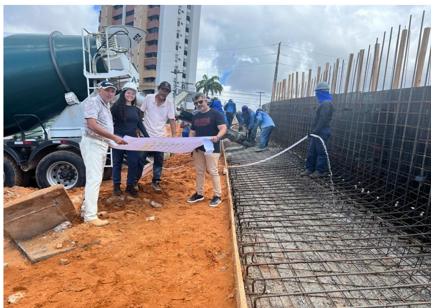
Figura 12: concretagem Contenção Secundária – Muro L .
