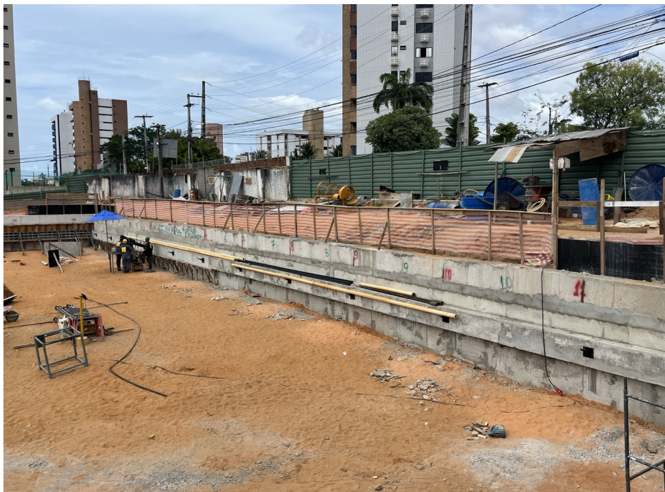
Figura 9: Protensão tirantes, contenção 1 trecho C.
