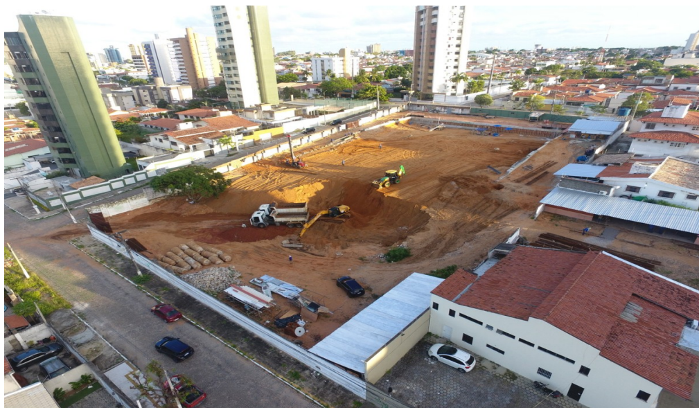
Figura 14: fundação da edificação anteriormente demolida.
