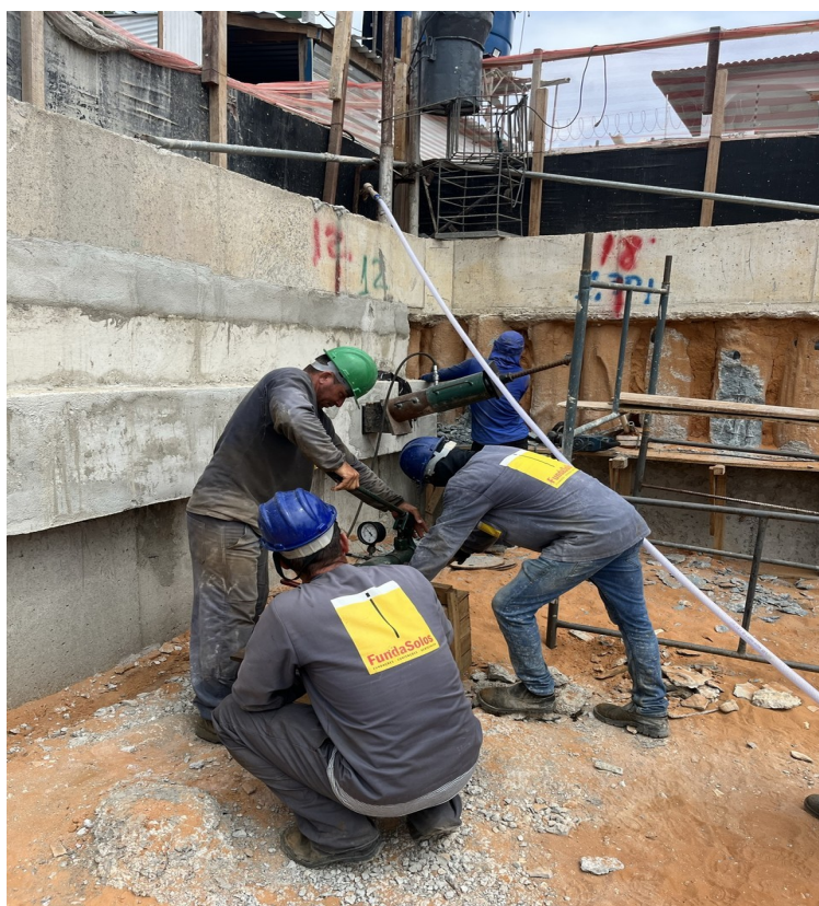
Figura 10: Protensão tirantes, contenção 1 trecho C..
