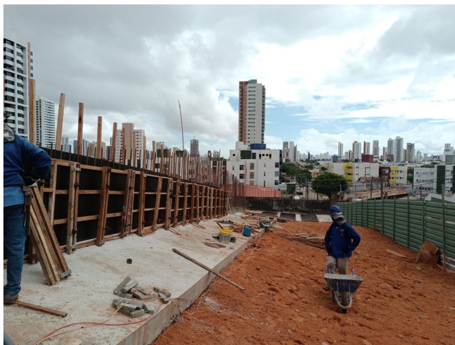
Figura 13: Contenção Secundária – Muro L após concretagem do trecho
