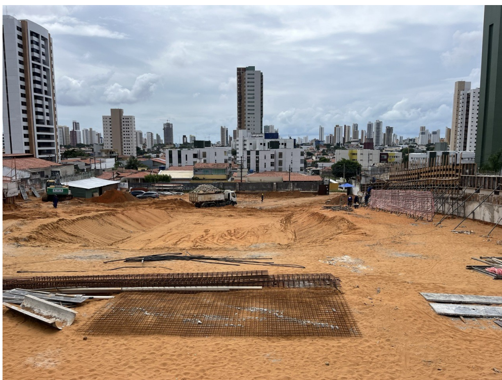
Figura 3: escavação, carga e transporte de solo.
