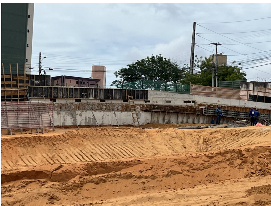
Figura 6: contenção 1 trecho B, estacas e viga de coroamento finalizadas.
