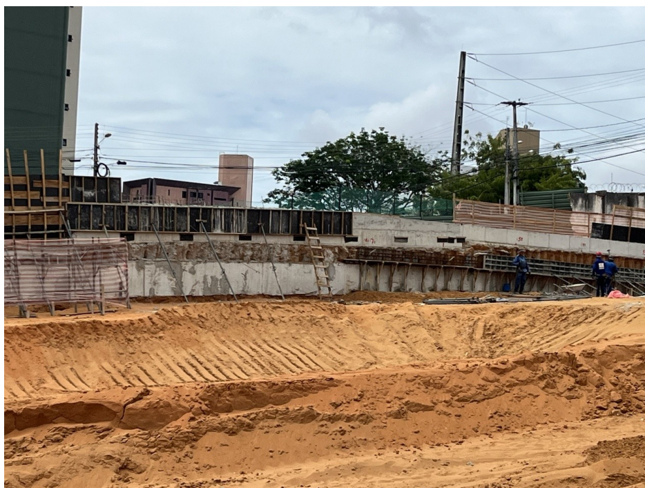
Figura 11: Revestimento de concreto armado com tela metálica para cobrir as estacas de contenção.
