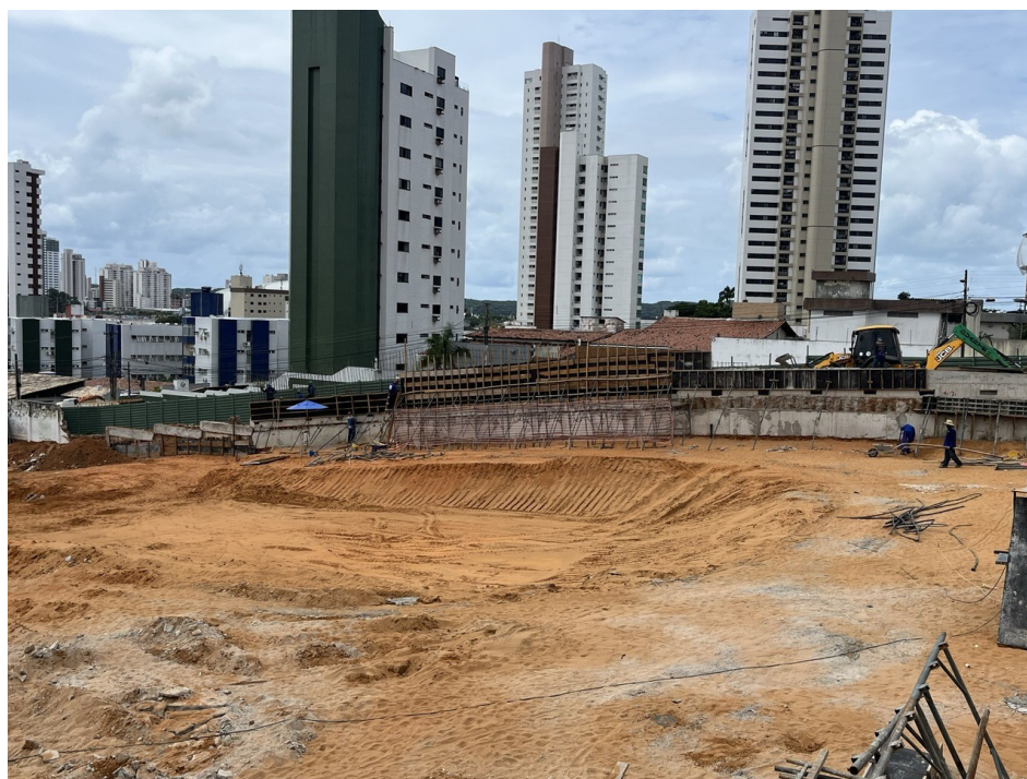
Figura 4: escavação e carga de solo para executar a segunda linha de tirantes.
